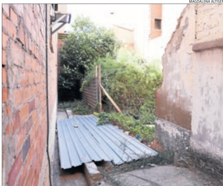
Una parcel·la en mal estat a la part antiga dels Magraners.
