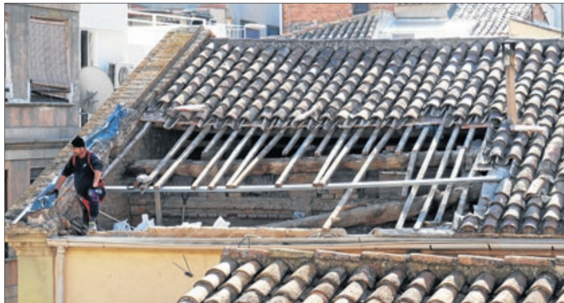
Un operari treballant ahir a la zona de la teulada de la capella que es va enfonsar al juliol per les pluges.
