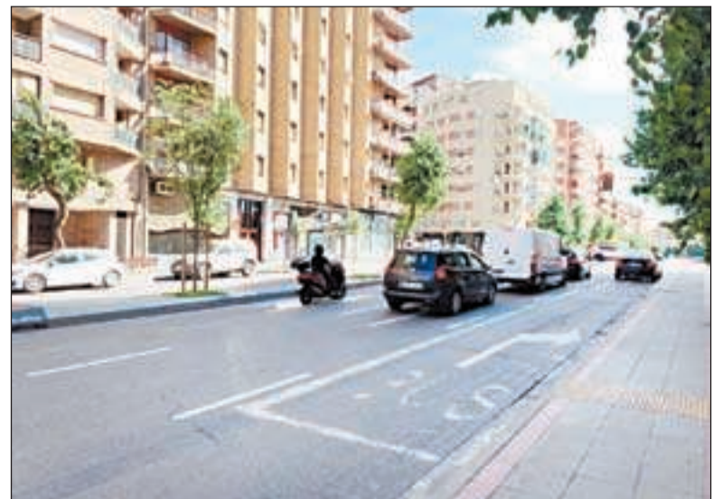
FOTO: Paeria / Algunes marques del terra estan en molt mal estat
